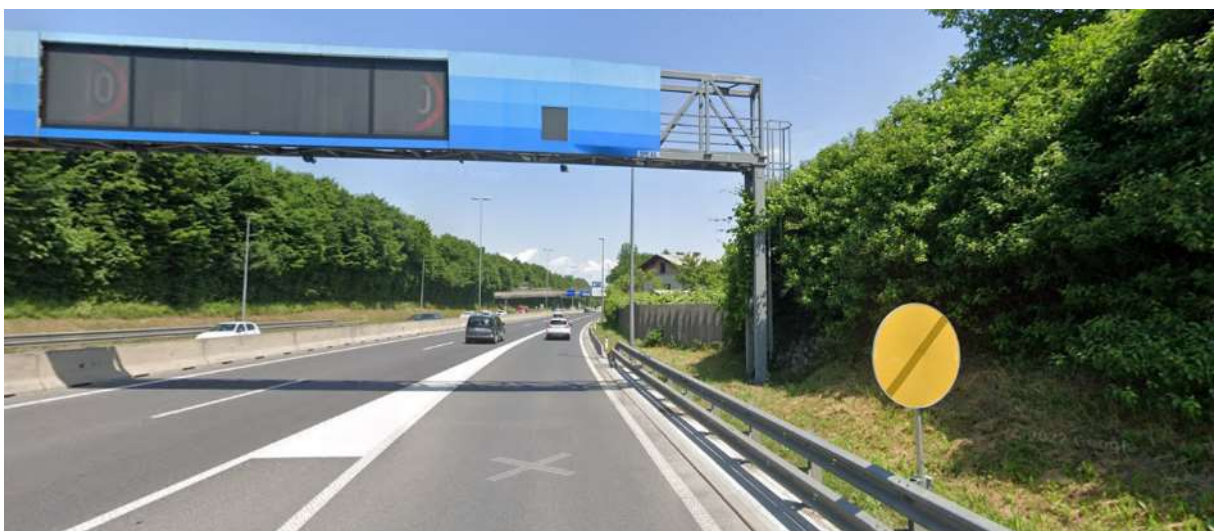
Slika 25: SPIS portal na območju APO-19e in betonska PHO, ki se odstrani in nadomesti z APO-19d
